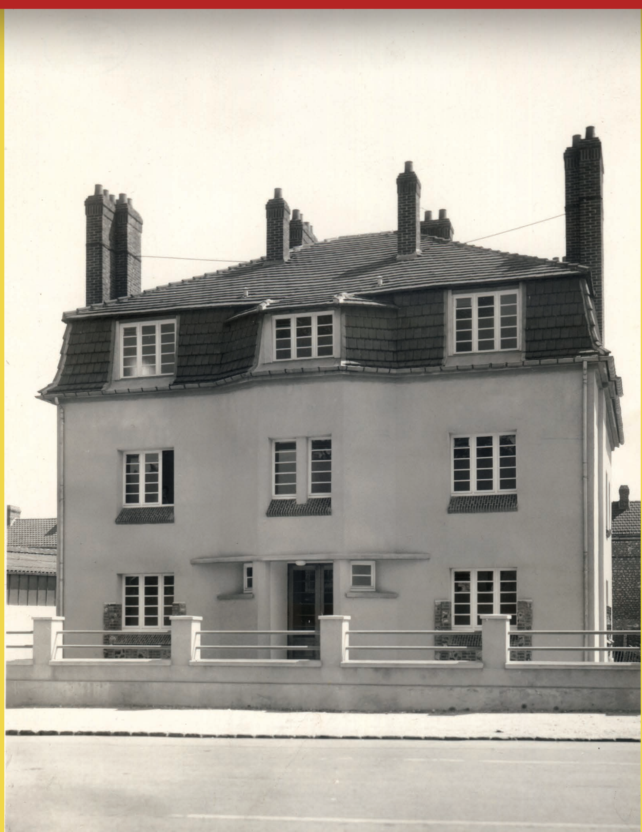
Façade de la maternité avenue des Alliés
