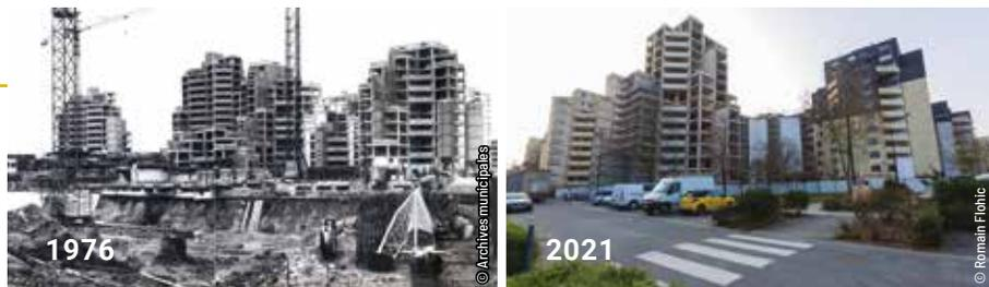
L’architecte propose un type de construction résolument novateur, commercialisé sous le nom de modèle Innovation. Celui-ci est basé sur l’emploi de cellules qui mesurent chacune 4,30 x 4,30 m. Leur mise en œuvre sous forme de grappes permet ainsi de jouer avec la hauteur des immeubles, de créer des formes pyramidales offrant la possibilité d’aménager balcons et petites terrasses.
