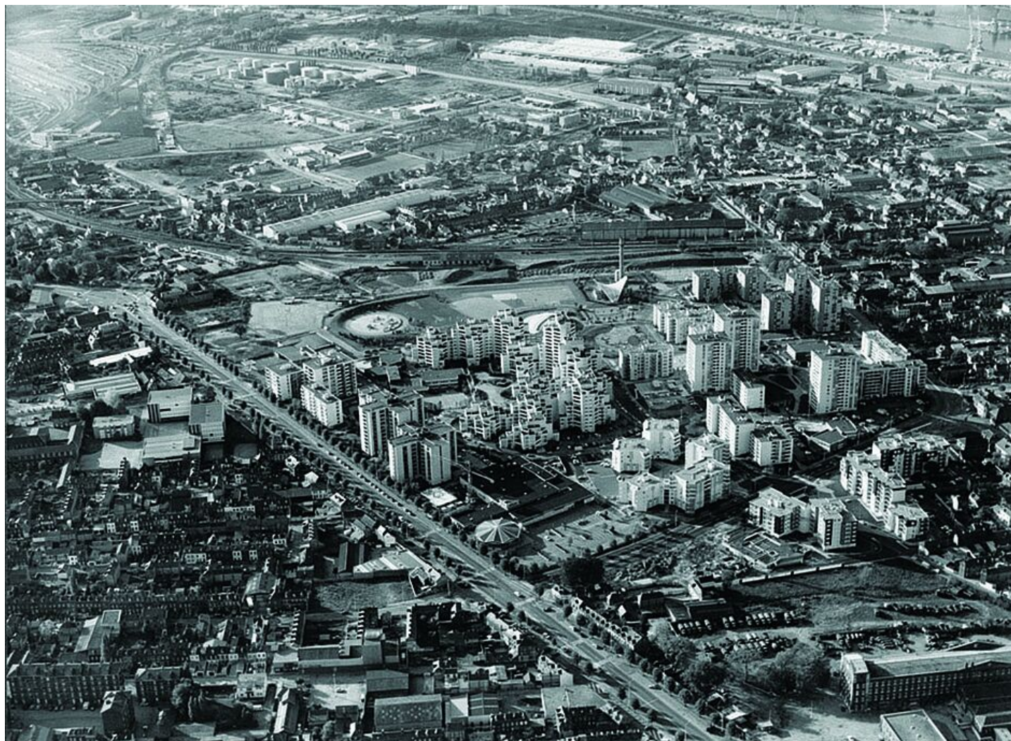
Vue aérienne du quartier Nobel (actuel quartier de la piscine) en 1982 - archives municipales de Petit-Quevilly
